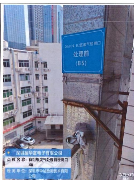
DA001 有组织废气处理前检测口 4# (B5)
