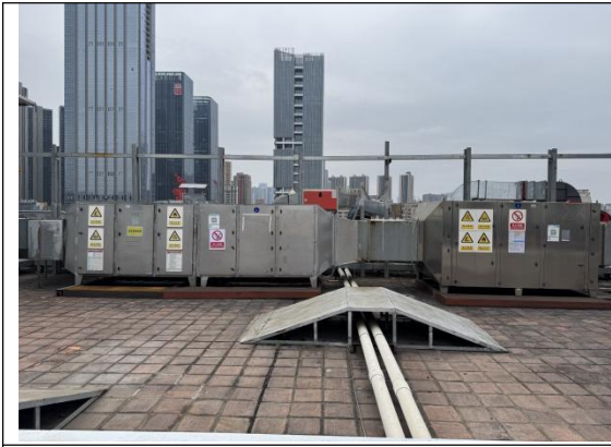
B1 区有机废气处理设施（前采样口 5#、6#）， 设计风量 30000m 3 /h
