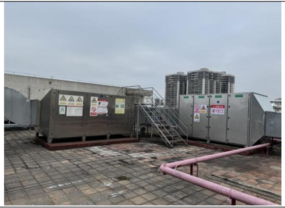
B2 区有机废气处理设施（前采样口 1#、2#、 3#、4#），设计风量 35000m 3 /h
