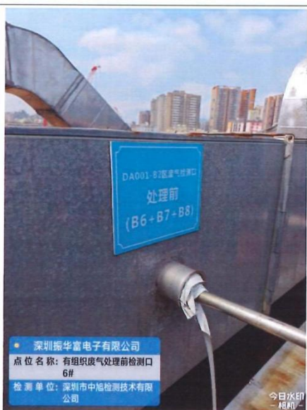
DA001 有组织废气处理前检测口 6# (B6、B7、B8)
